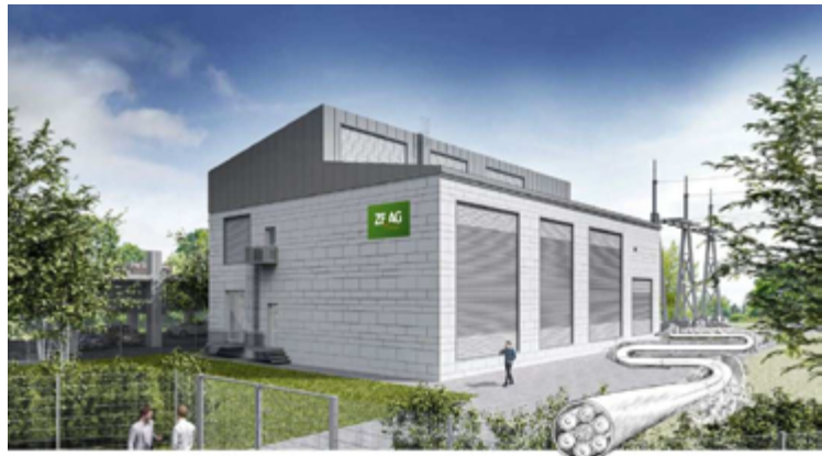
Im Bau befindliches Umspannwerk Lauffen-West
