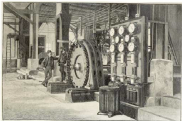
Erste Drehstromübertragung 1891 von Lauffen am Neckar nach Frankfurt
