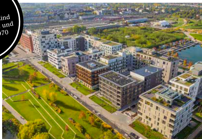
Energetisch auf dem neuesten Stand: der Neckarbogen in Heilbronn
